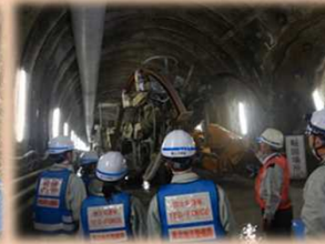
現場体験：月山地すべり 「志津地区排水トンネル」
