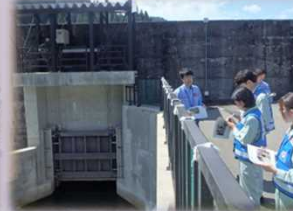
現場体験：堰堤を利用した小水力発電 （榎玉砂防堰堤）
