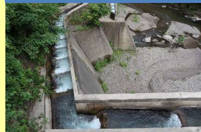
乙母砂防堰堤
