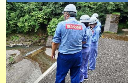
乙母砂防堰堤
