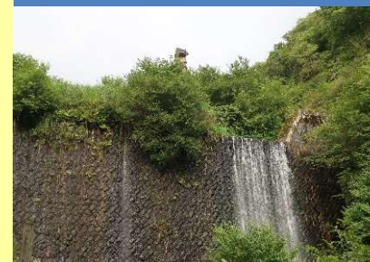
榛名川上流砂防堰堤
