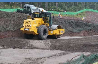
小滝沢砂防堰堤
