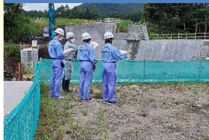
湯尻川下流砂防堰堤
