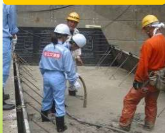
コンクリート打設体験
