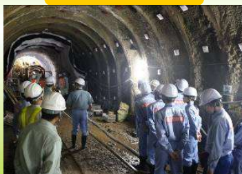
施工現場見学
