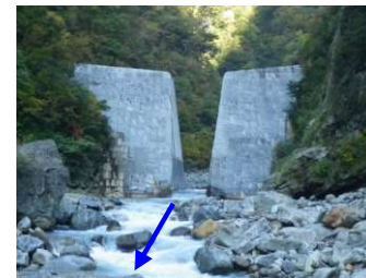
祖母谷第2号下流砂防堰堤
