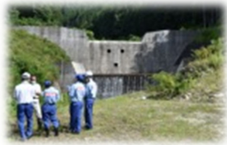
梨子沢第3砂防堰堤
