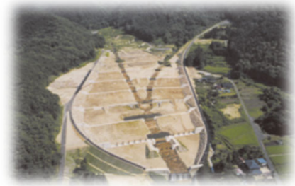
四ツ目川遊砂工
