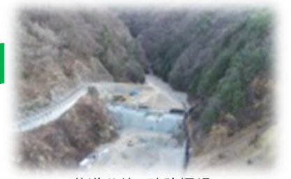
荒道谷第1砂防堰堤
