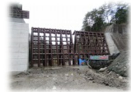
十王沢第2砂防堰堤
