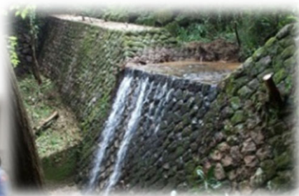
浦山第2砂防堰堤 (有形登録文化財)
