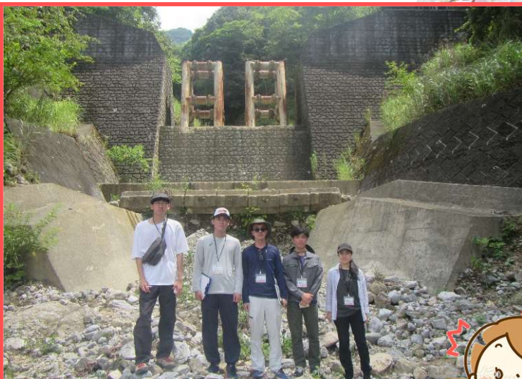
大迫力の堰堤を間近に見れる！
